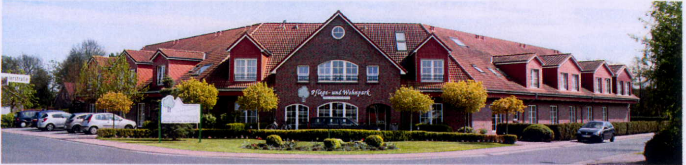
Frontansicht: Der „Wohnpark zwischen den Wieken“ an der Liebigstraße
